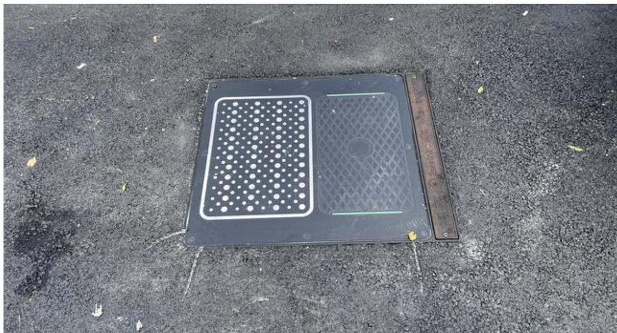
Am Boden des Taxistandes befinden sich diese Platten, über welche die E-Taxis aufgeladen werden können. Foto: Kathrin Klemm hochgeladen von Kathrin Klemm
